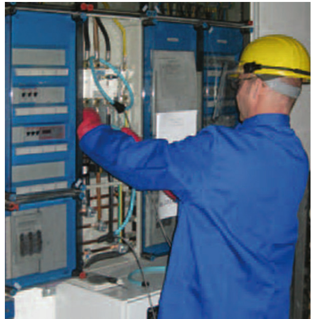
Bild 7: Einbau eines Netzanalysators in eine Verteilung
